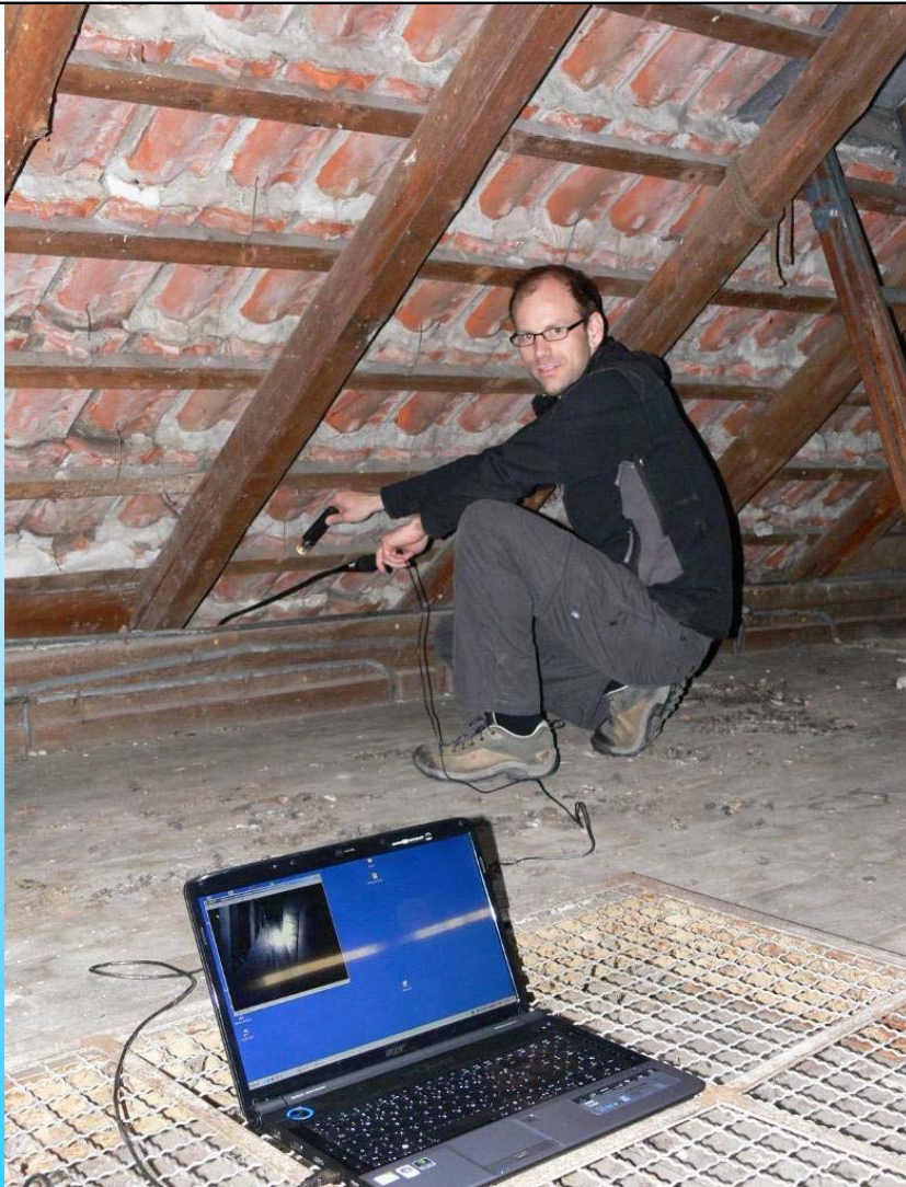
Kontrolle von nicht einsehbaren Spalten mittels Endoskop
