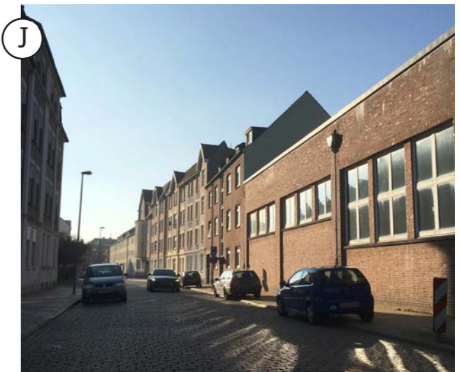
Abb. 17: Blick in die Theodor-Sturm-Straße
