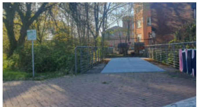
Abb. 2.51 – Fußgängerbrücke Ost (gesperrt)
