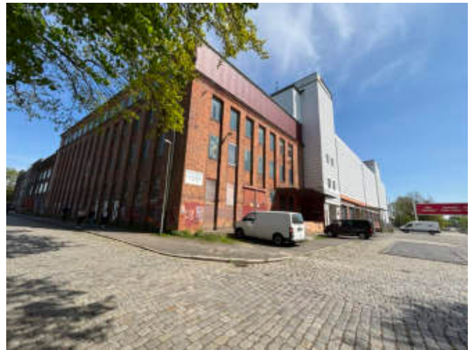
Abb. 2.9 – ehem. Fabrikgebäude der Norddeutschen Lederwerke, Wrangelstraße 34a
