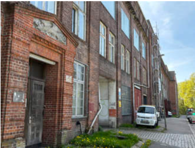
Abb. 2.8 – ehem. Fabrikgebäude der Norddeutschen Lederwerke, Wrangelstraße 34
