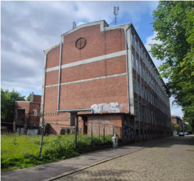
Abb. 2.6 – ehem. Fertigungsgebäude der Tuchfabrik Julius Bartram, Wrangelstraße 2-9
