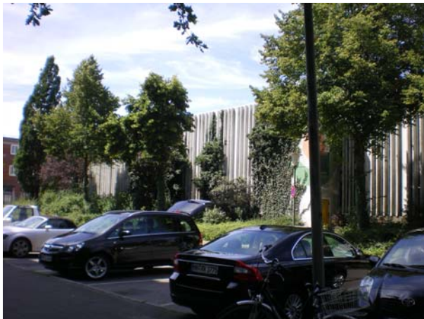
Fassadenbegrünung, Bepflanzung am Parkhaus
