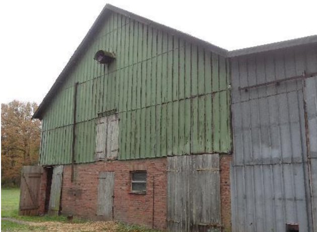
Abbildung 13: Scheune mit Heuboden und Blechanbau
