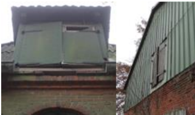
Abbildung 6: Dachgaube und Luken an Scheune
