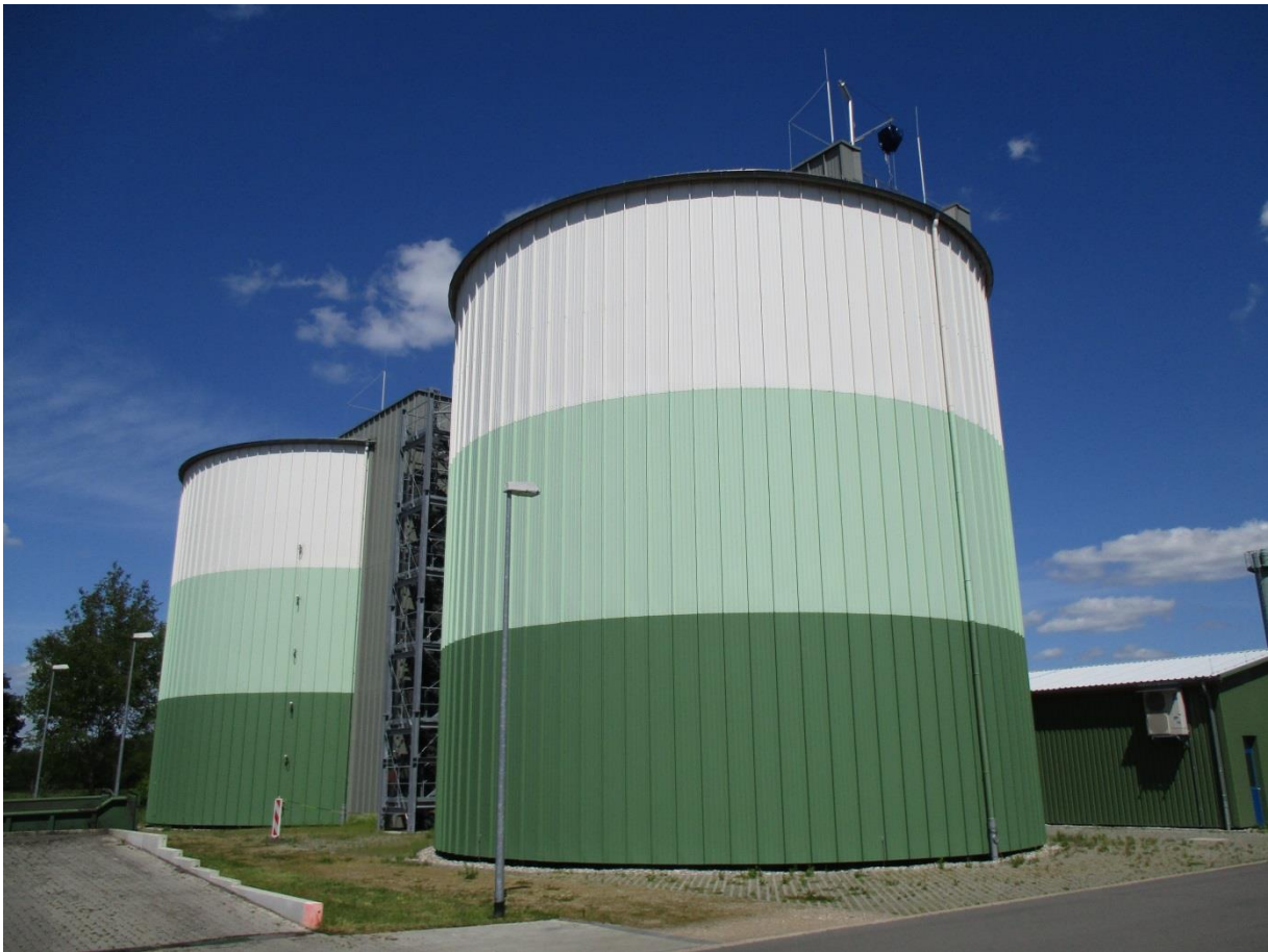
Abbildung 3 - Schlammfäulung der Kläranlage
