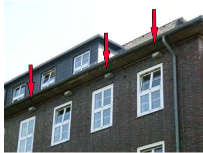
Mauerseglerkästen am Stadthaus Brachenfelder Str. 1-3 (Rückseite)
