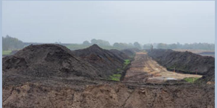
Massiver Oberbodenabtrag auf einer Großbaustelle. Die Bodenmieten sind weit größer als die erlaubte Aufschüttungshöhe.
