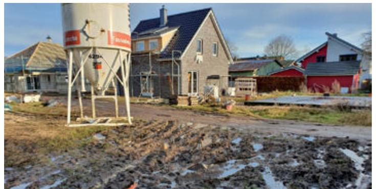
Stark beschädigter Oberboden durch Befahren mit schweren Fahrzeugen. Es wurden weder die Witterungsverhältnisse beachtet noch eine temporäre Baustraße errichtet. Durch die Verdichtung des Bodens entsteht nun dauerhaft Staunässe bei Niederschlag.
