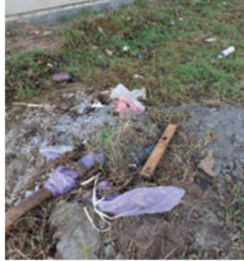
Bauschutt wurde nicht fachgerecht gesammelt und vermischt sich mit dem darunter befindlichen Oberboden. Das Anlegen einer Rasen- oder Pflanzenfläche wird nach Fertigstellung durch die Verunreinigung ohne Oberbodenaustausch kaum möglich sein.
