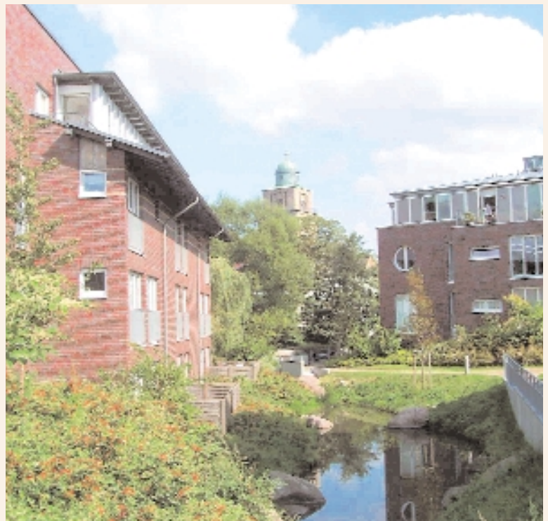
Baugelbiet „Simonssches Gelände“
