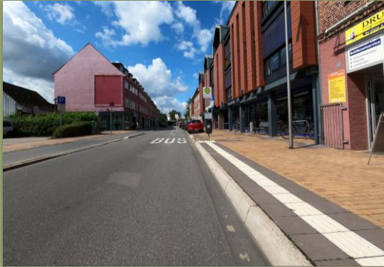
Bushaltestelle mit taktilen Elementen (Wasbeker Str.)
