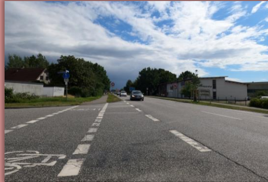
Gefährliche Querungssituation durch Zweirichtungsrادweg (Boostedter Str.)
